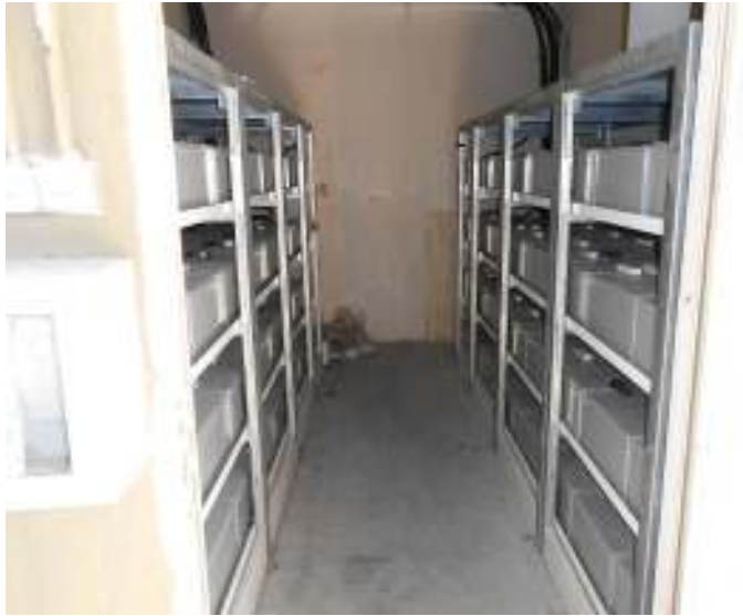
Εικόνα 1. Ερμάρια τοποθέτησης συσσωρευτών ενός UPS.
